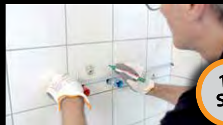
Schritt 2: Wandanschlüsse versetzen und Wand auffüllen
