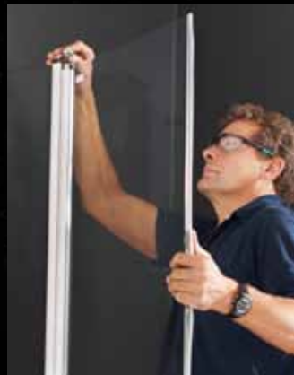
6 Für die Befestigung des Türsegments wird das obere Lager aufgeschraubt und die Tür eingehängt.
