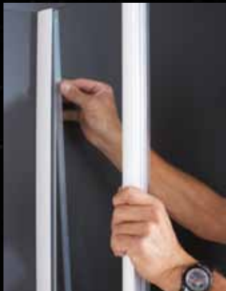
5 Eine Klemmleiste fixiert das Glassegment zuverlässig in der Wandleiste.
