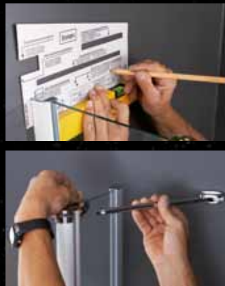
10 Die mitgelieferte Schablone erleichtert das Anzeichnen der Bohrlöcher für den Stabilitätsbügel.
