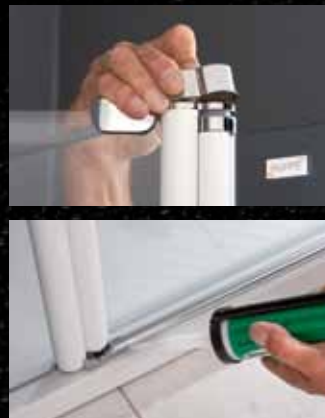
12 Anschließend werden die Abdeckkappen an allen vertikalen Profilen aufgesetzt.
