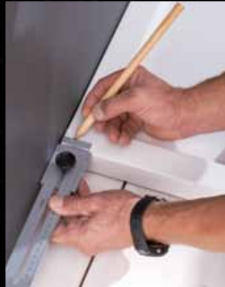
2 Vor der Montage der Duschtrennung wird ein 10 mm tiefer Rücksprung auf dem Wannenrand angezeichnet.
