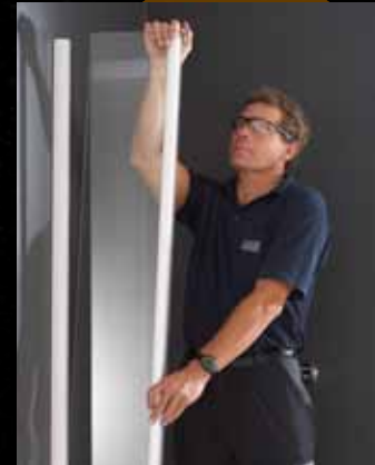
4 Nach Montage der Wandleiste wird das feste Segment eingesetzt.
