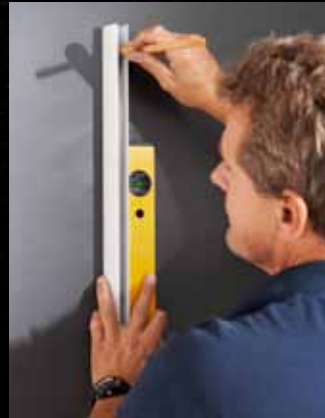
3 Die Bohrlöcher für die Schrauben der Wandleiste werden angezeichnet, indem die Wandleiste passgenau an die Markierung des Rücksprungs angelegt wird.
